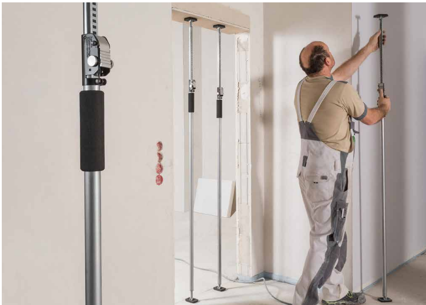
Puntelli telescopici con regolazione a vite e perno di fissaggio Pag. 810
